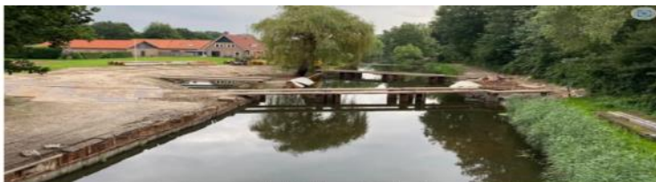
De aanleg van een vissentrap links en stuw in het Valleikanaal. Op de achtergrond de plek waar ooit herberg de Roode Haan stond. De fundering ervan ligt nog onder het nieuwe huis.
